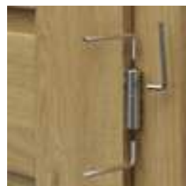
regulacja zawiasów czopowych regulowanych 3D
